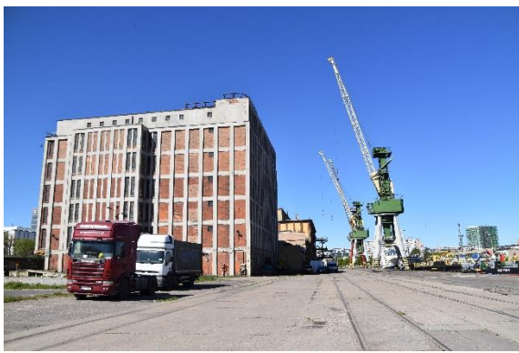
Fotografia 33 Budynek chłodni nr 2 przy nabrzeżu Angielskim (fot. Ekovert)
