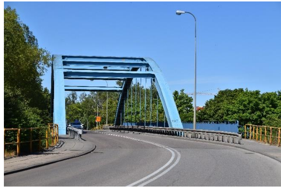
Fotografia 28 Wiadukt w ciągu ul. Wendy (fot. Ekovert)
