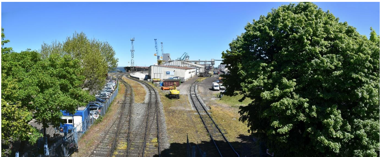
Fotografia 15 Widok na część zabudowy portowej przy ul. Węglowej (fot. Ekovert)
