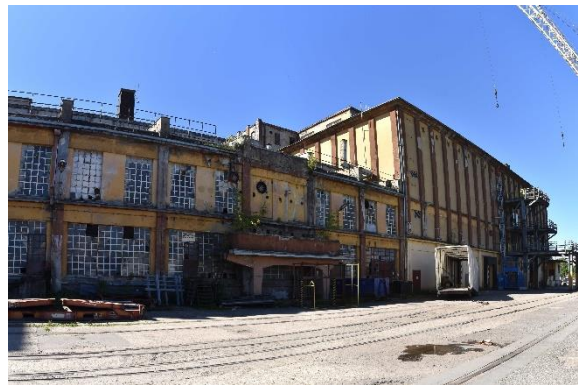
Fotografia 30 Budynek chłodni przy nabrzeżu Angielskim (fot. Ekovert)
