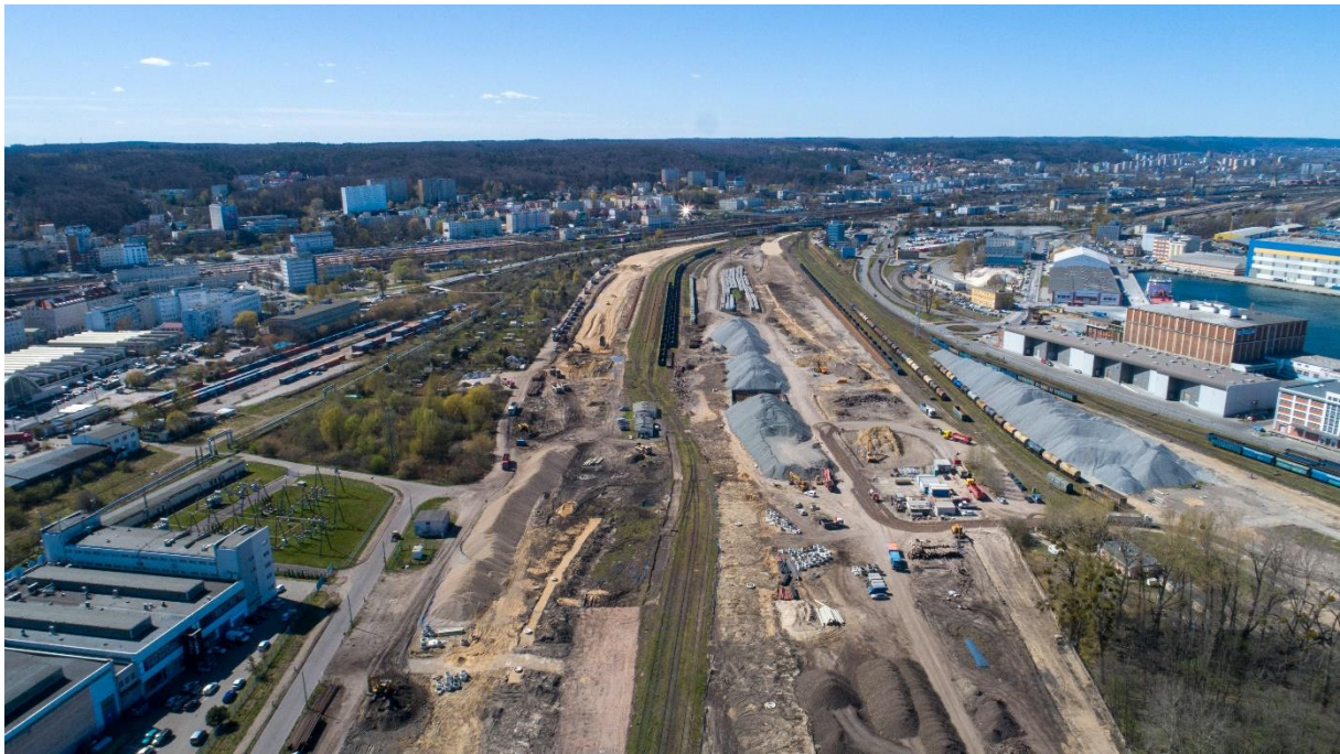
Fotografia 12 Widok z lotu ptaka na obszar prac związanych z budową nowego torowiska kolejowego (fot. Port Gdynia)
